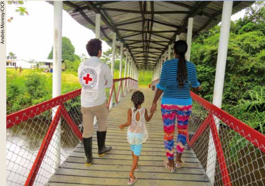
Para los niños de la vereda Balsora, en Puerto Leguizamo (Putumayo), ir a la escuela podía representar un peligro por la presencia de artefactos y restos explosivos. Este puente sobre el río Piñuña Negra, construido por el CICR, ayudó a reducir el riesgo.
